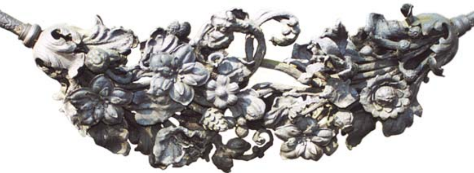
3. Grób Romana Szewczykowskiego z 1902 r. na warszawskich Powązkach. Fragment ogrodzenia wykonanego z kutego żelaza, poddany konserwacji metodą rzemieślniczą powodującą zatarcia najdrobniejszych reliefów.
