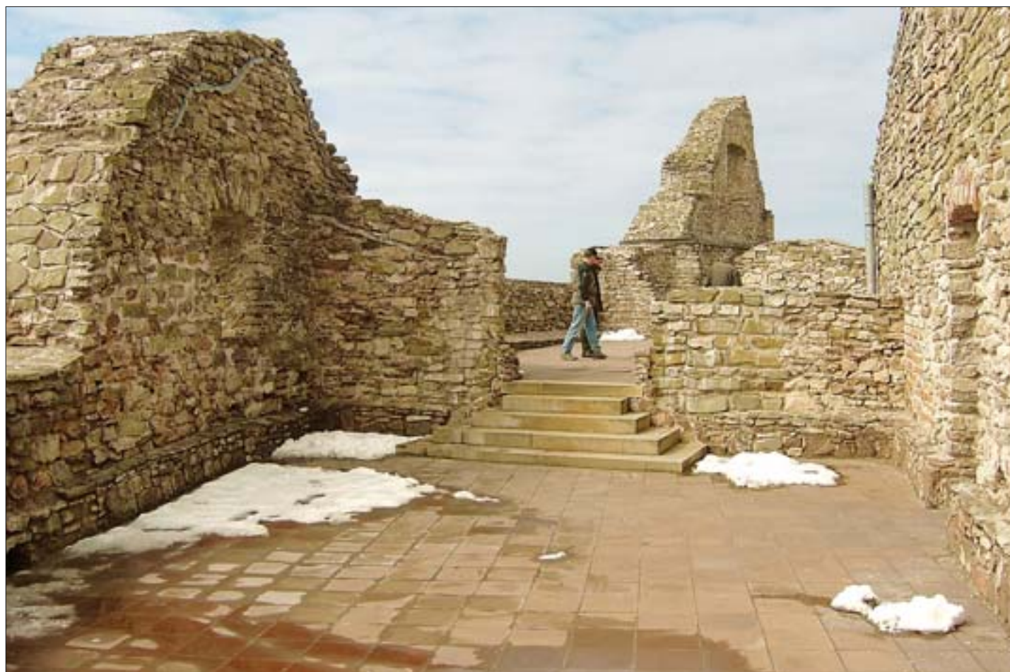
16. Tarasy widokowe na poziomie I piętra zamku górnego po zakończeniu prac zabezpieczających. Fot. P. Stępień, 2004 r.
