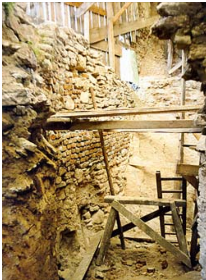
17. Dziedziniec zamku górnego w trakcie badań i wstępnych prac zabezpieczających. Fot. P. Stępień, 1993 r. 17. Upper Castle courtyard in the course of research and initial protection work. Photo: P. Stępień, 1993.
