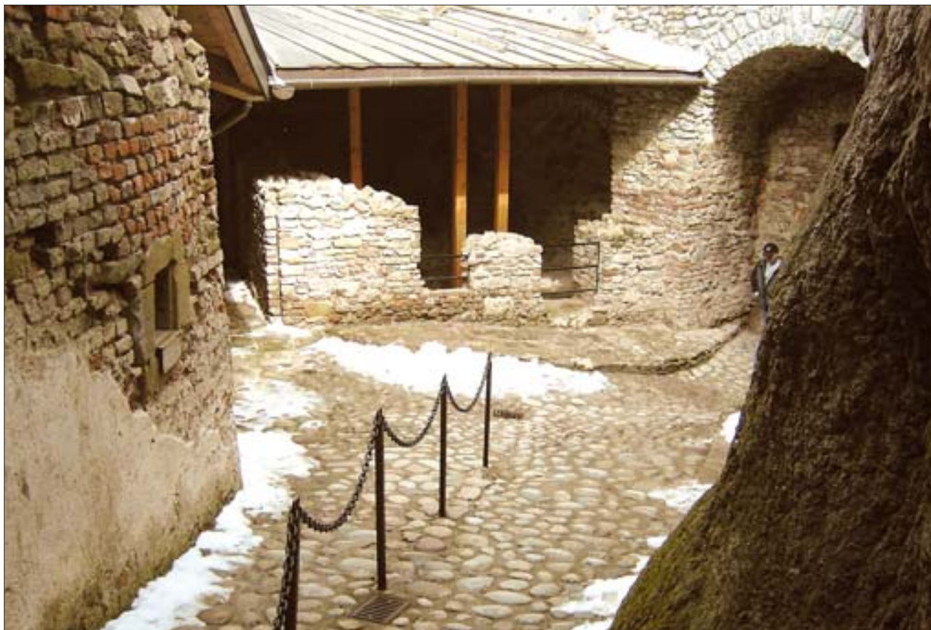
26. Dziedziniec zamku średniego po pracach zabezpieczających. Fot. P. Stępień, 2004 r. 26. Middle Castle courtyard after the application of protective measures. Photo: P. Stępień, 2004.
